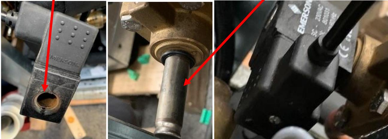
4) Remettre l'écrou de verrouillage et le positionner dans les ergots puis remonter le bouchon noir ou orange en le serrant à fond : la bobine est désormais bloquée
