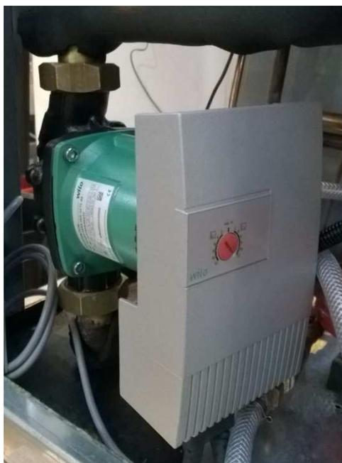
Le réglage du circulateur se fait à pression constante. Il faut manipuler le bouton vers la droite pour augmenter sa pression.
